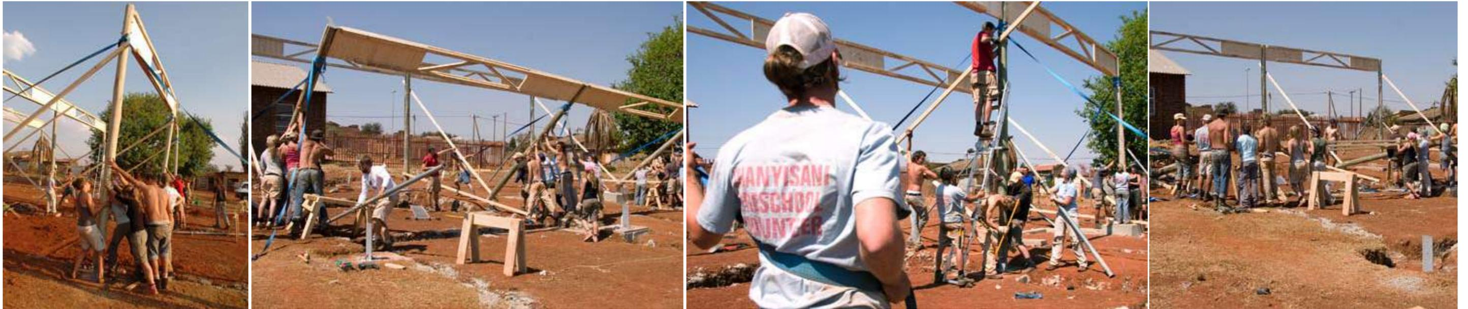
Die Hauptträger für das Dach wurden aus Dreischichtplatten und örtlichen Kanthölzern gefertigt, für die Stützen wurden Rundhölzer aus Eukalyptusholz, sogenannte Gumpoles, verwendet.
