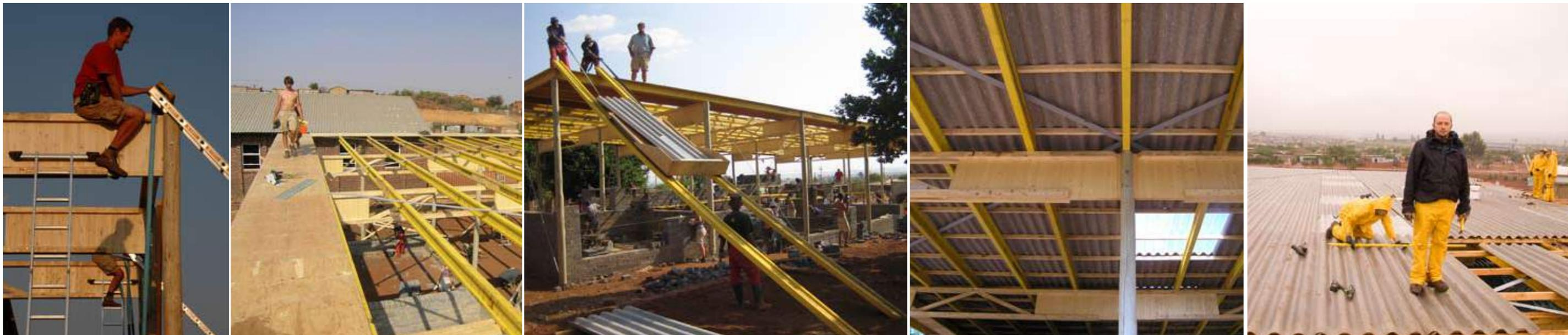
Die Dachdeckung auf der Holzkonstruktion wurde mit Welleternitplatten ‚Big 6‘ der Firma Nutec ausgeführt. Über dem zentralen Erschließungsgang sorgen Polycarbonatwellplatten mit der gleichen Wellengröße für zusätzliche Belichtung.
