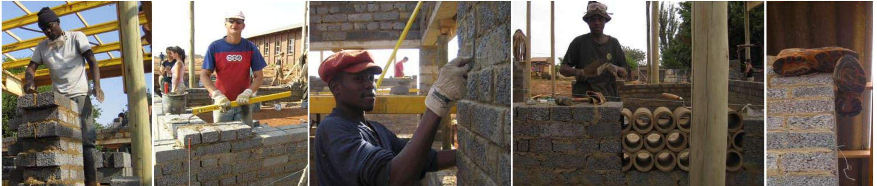
Das Mauerwerk für die Gebäude besteht aus den örtlichen Schlackensteinen. Alle Wände wurden zweilagig gemauert, um eine etwas bessere Dämmwirkung und vor allem genügend Speichermasse zu erreichen, wodurch im Sommer die Gefahr der Überhitzung verringert wird. Hinter den Betonröhren wurden Klappen eingebaut, die sich zur Nachtlüftung im Sommer öffnen lassen.
